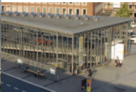
Radstation Münster mit Solaranlage.
